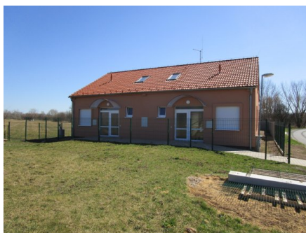
čelní pohled RD 5 a RD6
